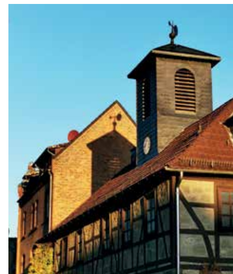
Die Alte Schule wird derzeit saniert.
